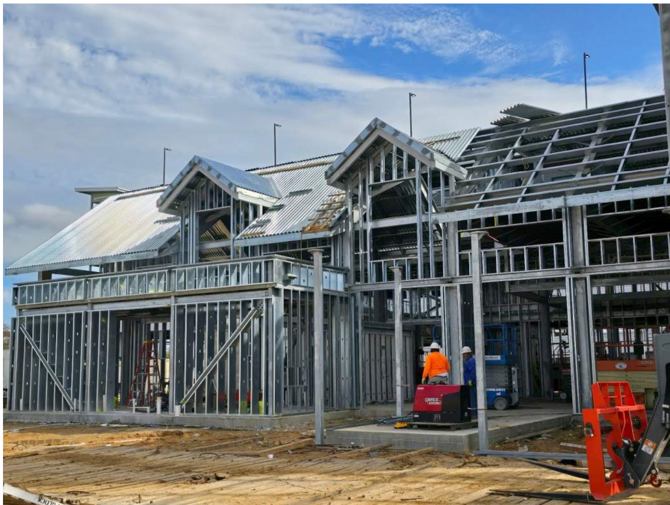
Figura 15 Construcción de viviendas unifamiliares con el KFS Framemaker 1220G3
