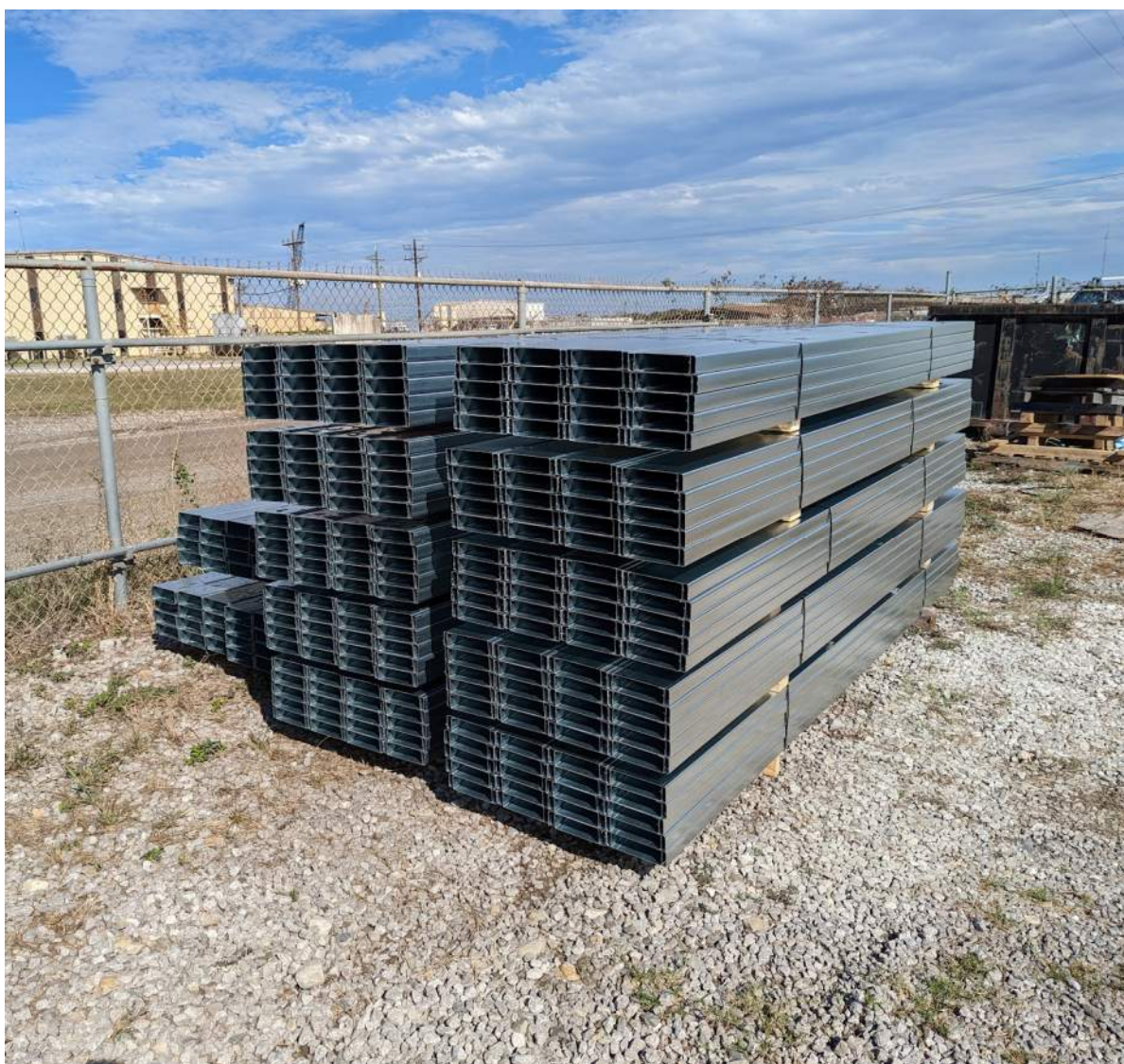
Figura 14 Suministro de montantes y canales SFIA con el KFS Framemaker 1220G3
