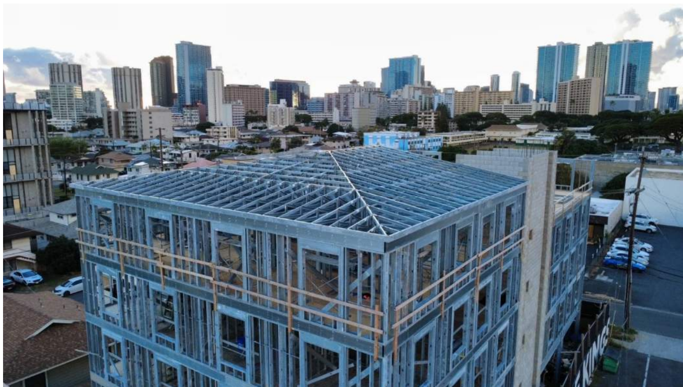
Figure 16 Construction de logements collectifs avec le KFS Framemaker 1220G3
