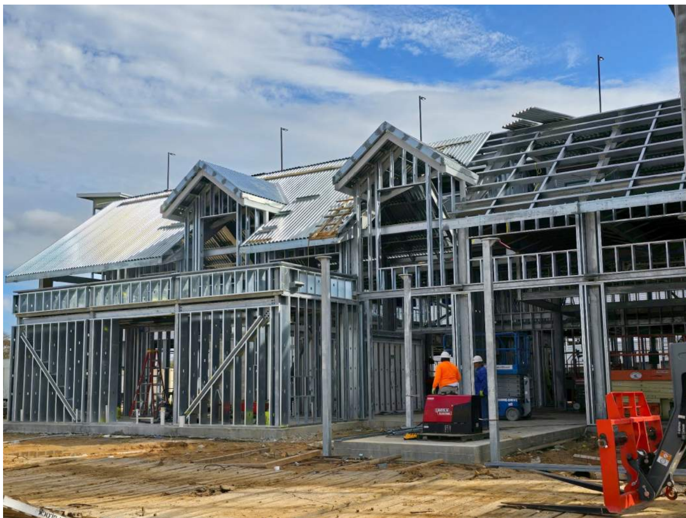
Figure 15 Construction de maisons individuelles avec le KFS Framemaker 1220G3
